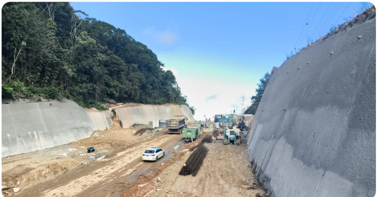
No acesso do lado de Guaratuba, tiveram continuidade os serviços de contenções, com a execução do solo grampeado, estaca raiz e a escavação para rebaixamento do morro
