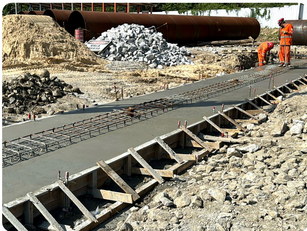
Foram iniciados os trabalhos preliminares para instalação da treliça lançadeira, que vai garantir ainda mais agilidade à obra
