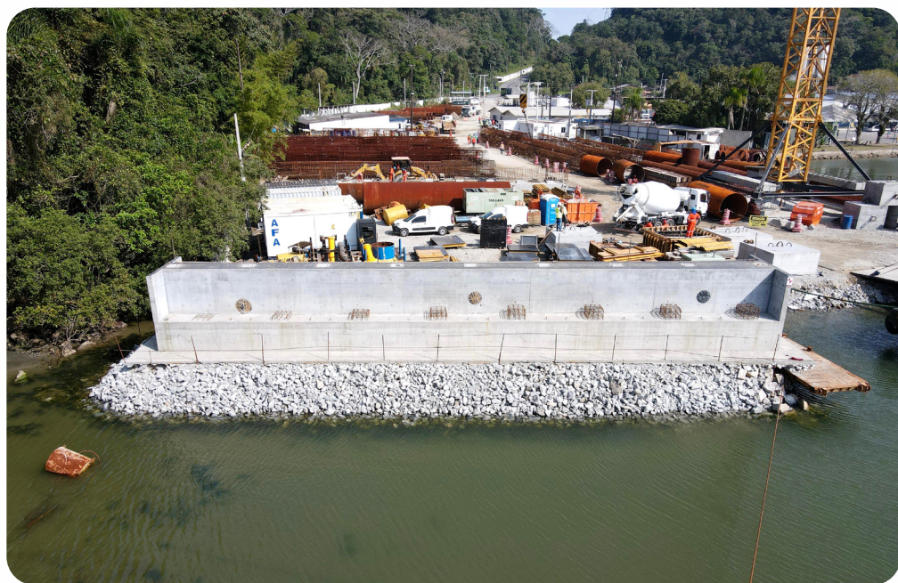
Já foram finalizadas duas vigas travessas e outras duas estão em andamento
