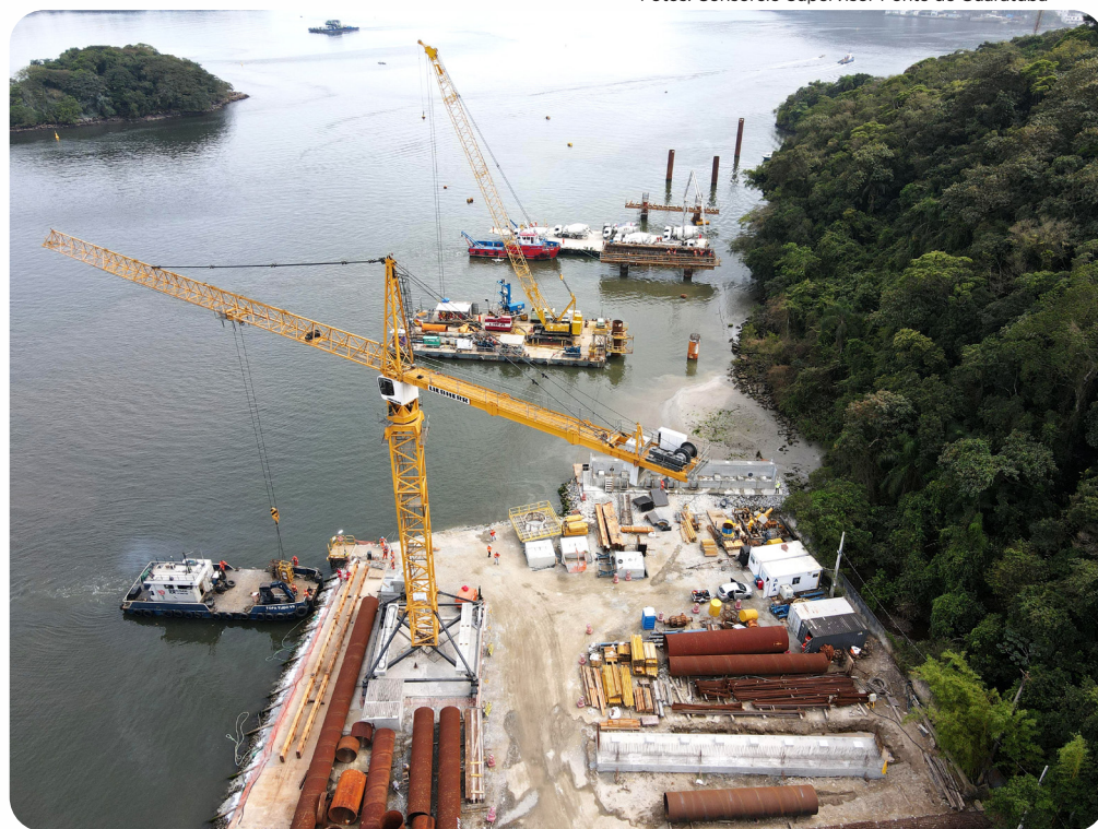
Em setembro, os trabalhos estiveram concentrados na execução das estacas e atividades de cravação, escavação e concretagem
