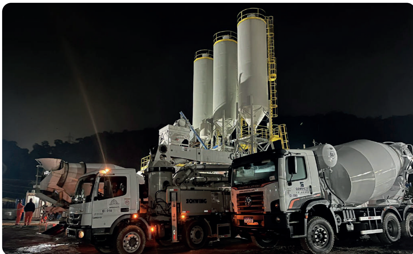
Betoneiras aguardando carregamento de agregados e cimento. Imagem: CSPG.
