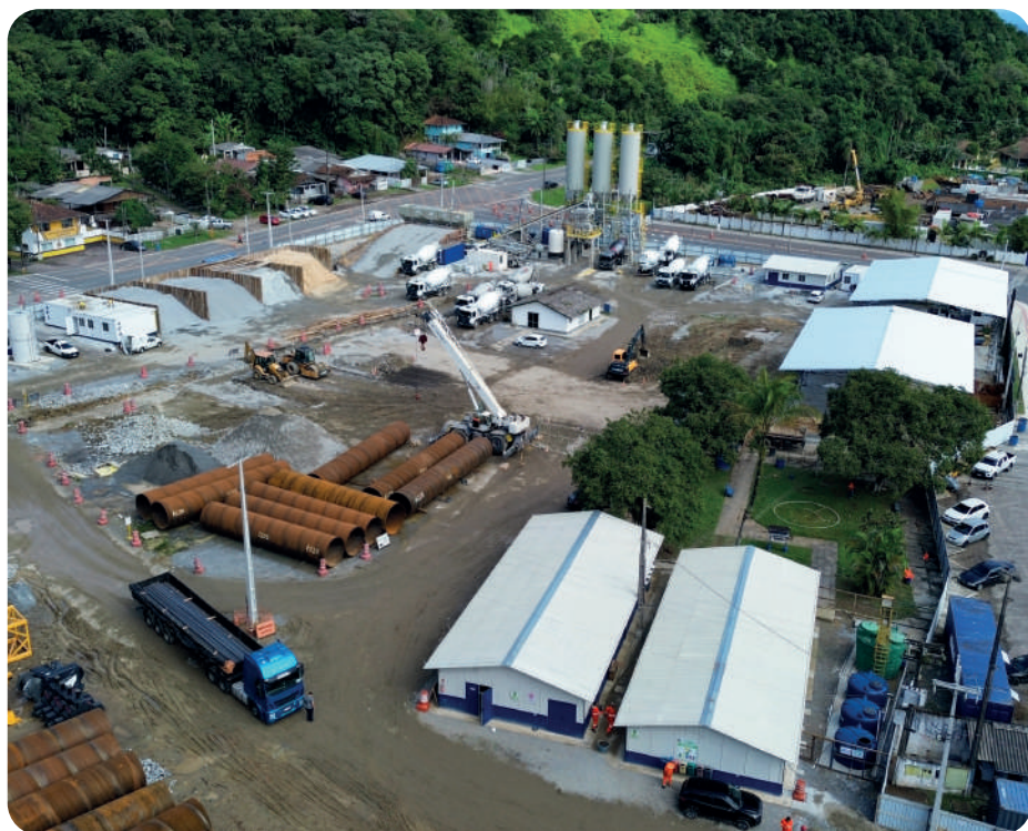
Vista aérea do canteiro industrial. Imagem: CSPG.
