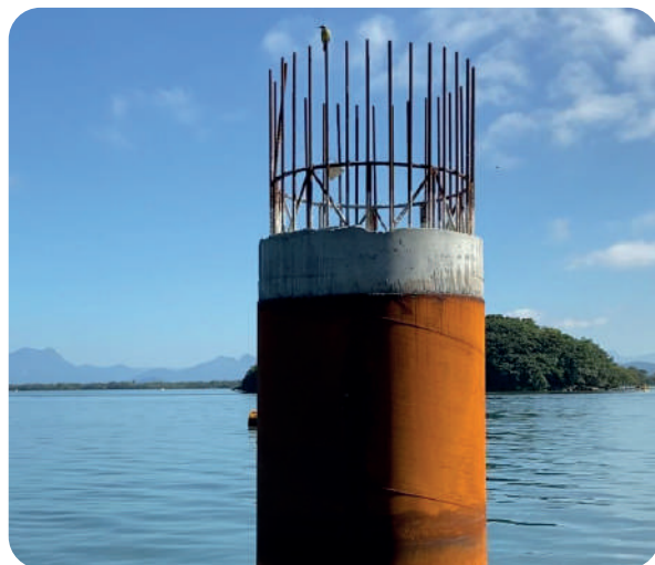
Estaca finalizada com concreto produzido in loco. Imagem: CSPG.
