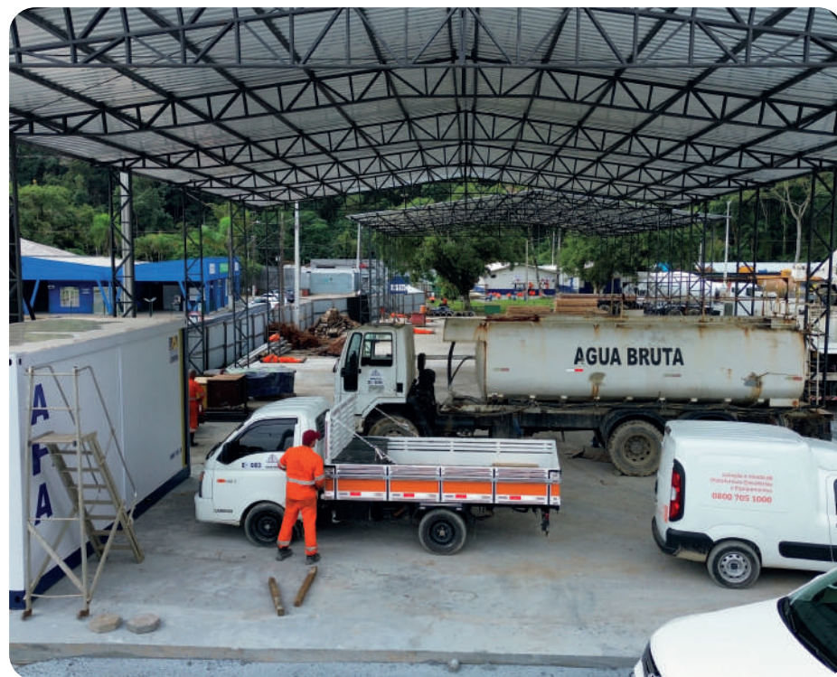
Galpão metálico para oficina e carpintaria. Imagem: CSPG.
