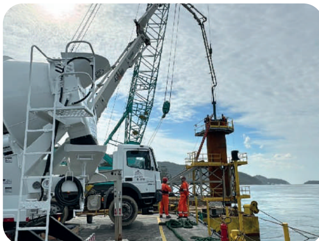
Execução da concretagem. Imagem: CSPG.
