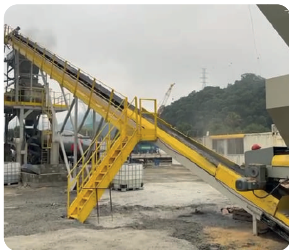
Esteira levando os agregados para o misturador. Imagem: CSPG.
