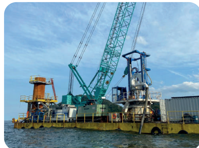
Fundação do Apoio 4 em execução. Imagem: CSPG.
