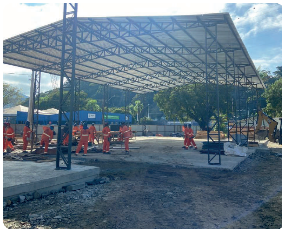
Galpão para carpintaria. Imagem: CSPG.
