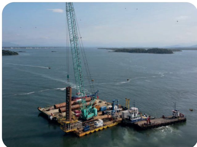
Instalação da camisa metálica para fundação offshore. Imagem: CSPG.
