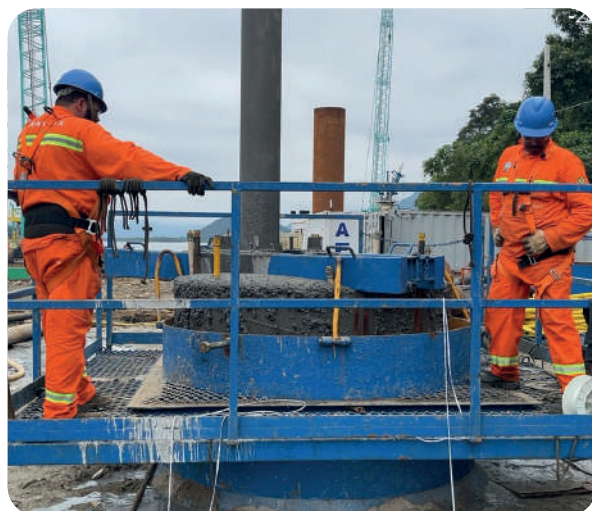
Processo de concretagem em andamento. Imagem: CSPG.
