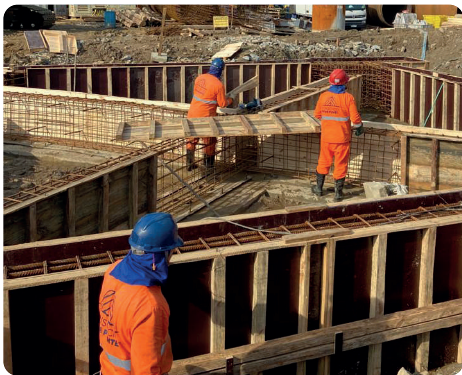
Fundação da base da grua. Imagem: CSPG.
