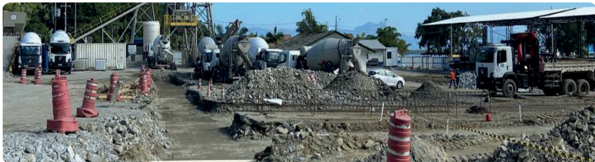
Pátio de vigas e área de apoio da treliça lançadeira. Imagem: CSPG.
