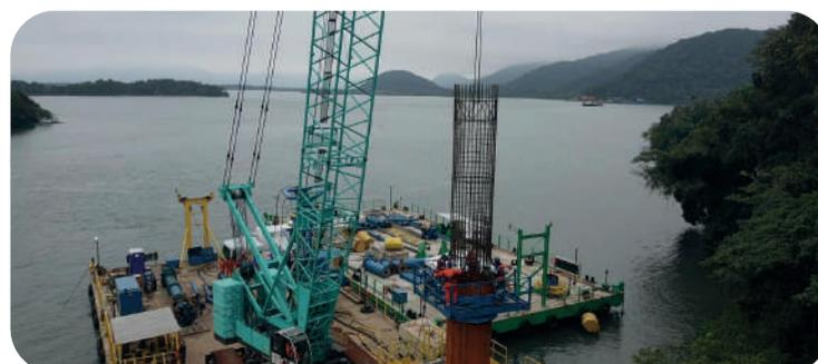
Içamento e verticalização da armadura para instalação dentro da camisa metálica.
