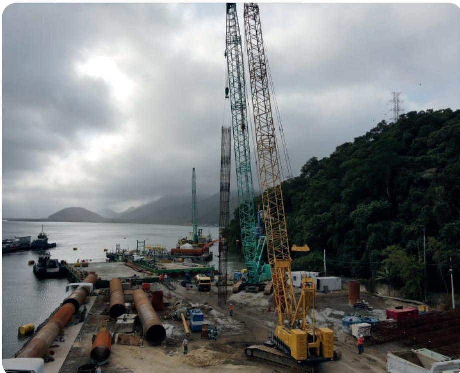
Içamento e verticalização de armação para fundação.
