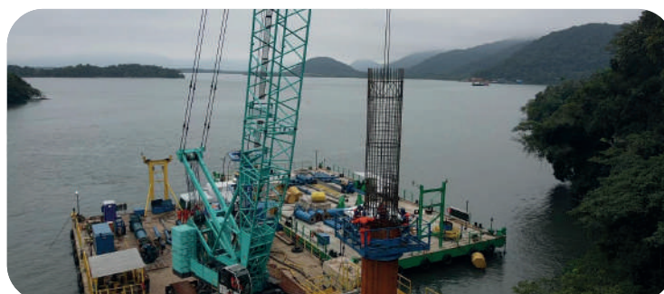
Içamento e verticalização da armadura para instalação dentro da camisa metálica. Imagem: CSPG.
