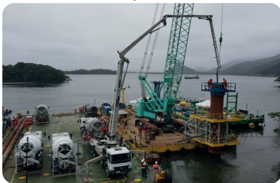
Processo de concretagem sendo realizado. Imagem: CSPG.
