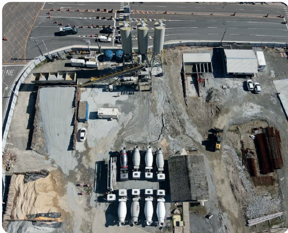
Vista aérea do canteiro industrial. Imagem: CSPG.
