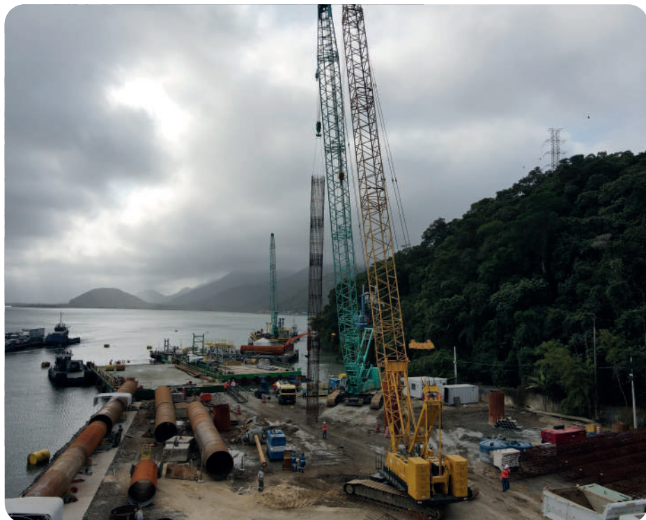
Içamento e verticalização de armação para fundação. Imagem: CSPG.
