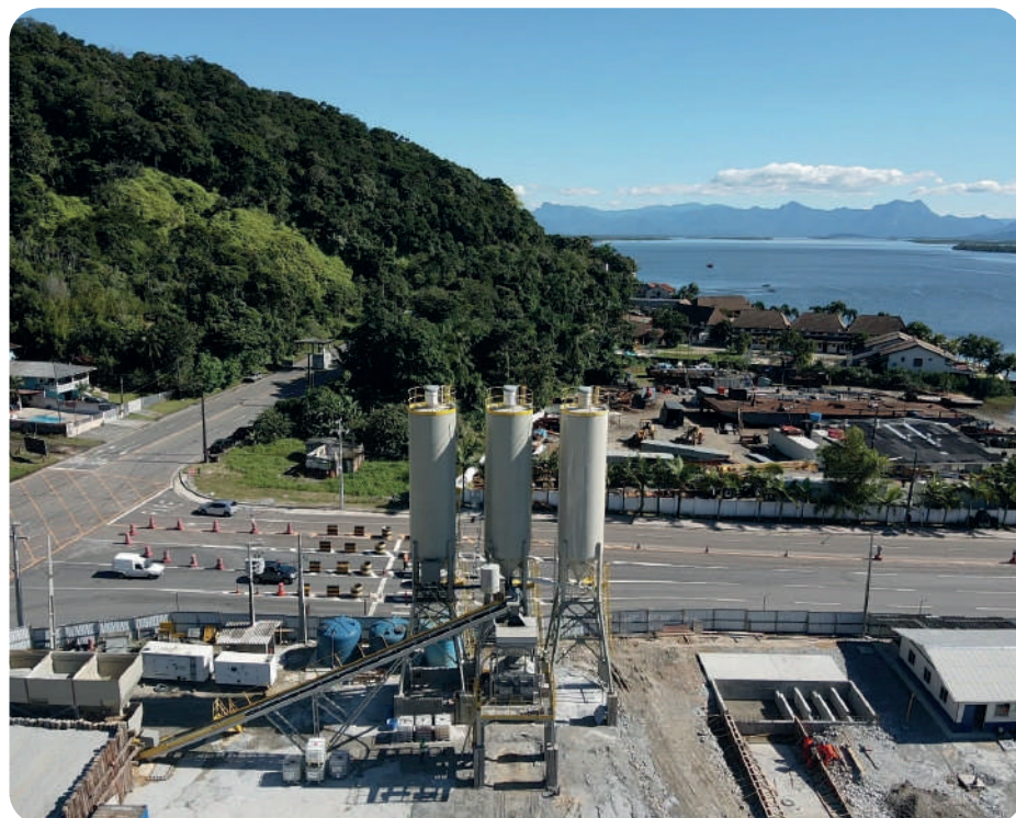
Vista aérea da usina de concreto. Imagem: CSPG.
