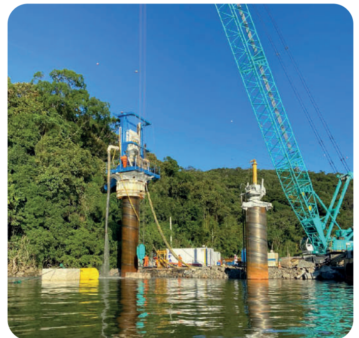
Processo de escavação do solo/rocha. Imagem: CSPG.
