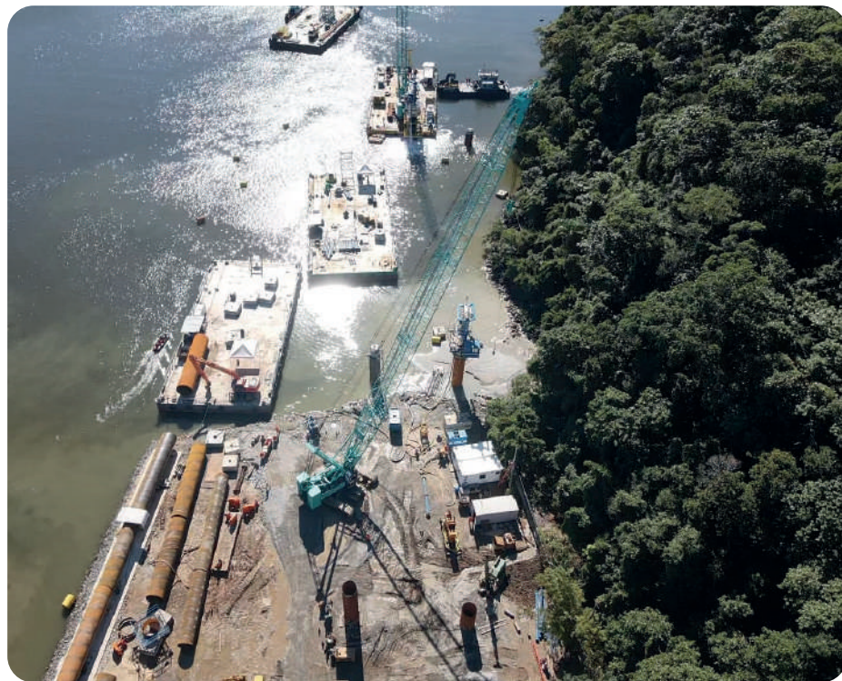
Vista aérea do local onde será a cabeceira da ponte. Imagem: CSPG.
