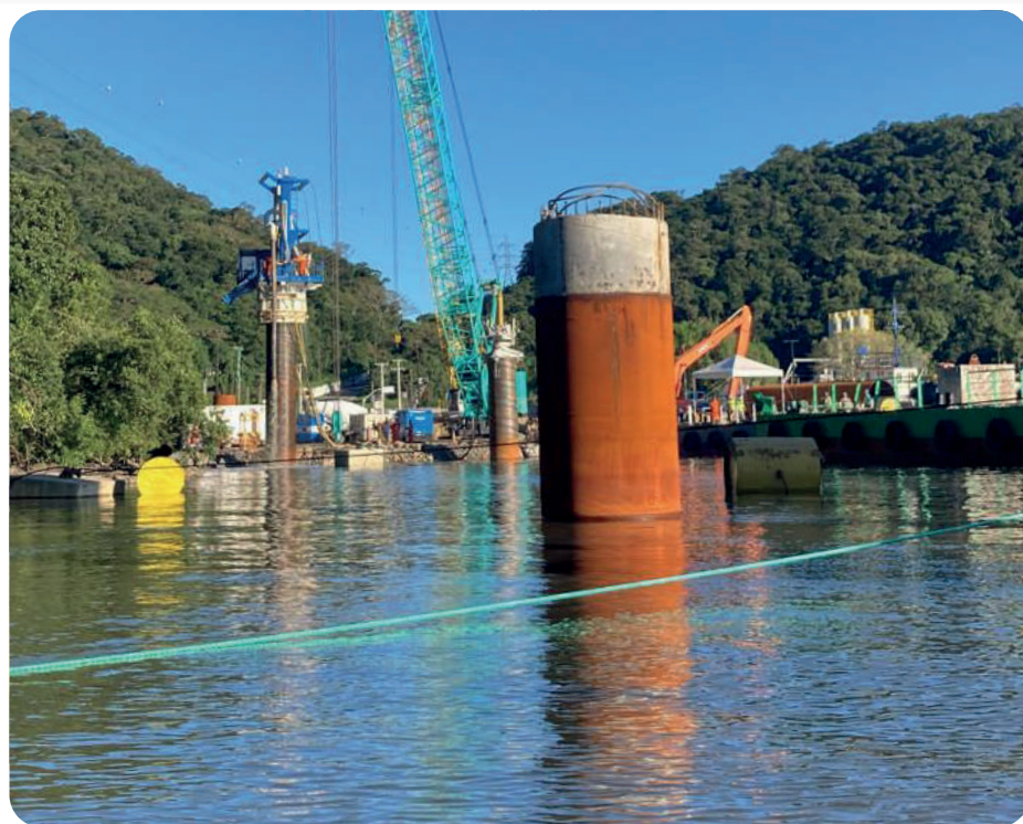
Primeira estaca concretada na Baía de Guaratuba. Imagem: CSPG.
