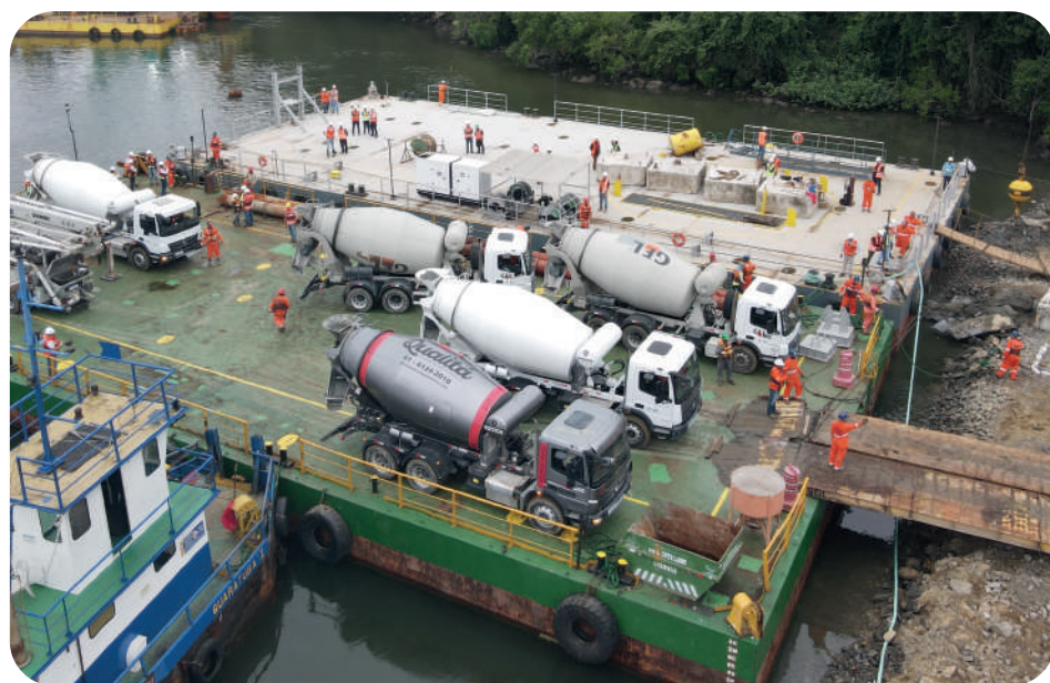
Caminhões betoneira preparados para a concretagem. Imagem: CSPG.
