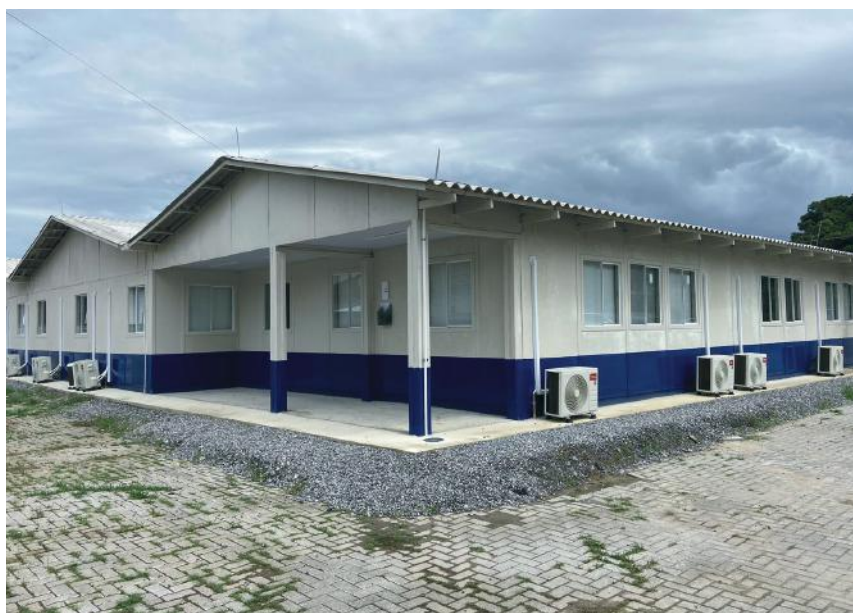
Escritório administrativo. Imagem: CSPG.
