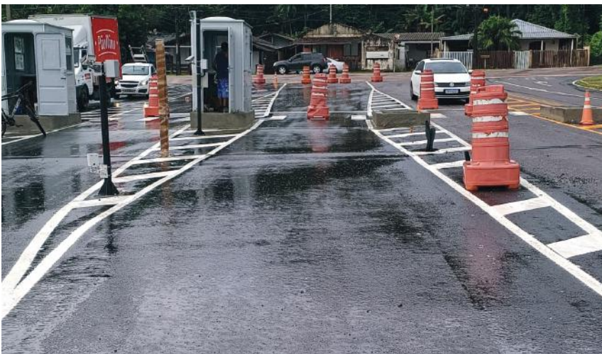
Novo trajeto construído para acesso aos Portos 1 e 2 em Guaratuba. Imagem: CSPG.
