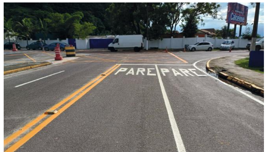
Sinalização para o novo trajeto construído para acesso aos Portos 1 e 2 em Guaratuba. Imagem: CSPG.
