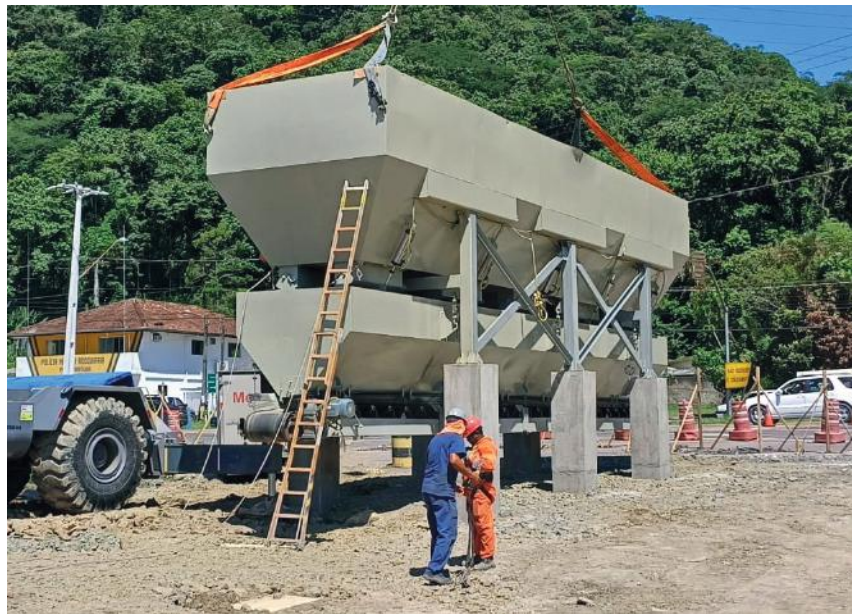
Caixas de armazenamento de agregados. Imagem: CSPG.
