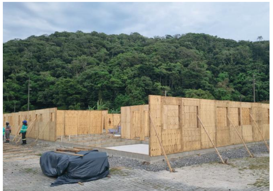
Obras no canteiro administrativo. Imagem: CSPG.
