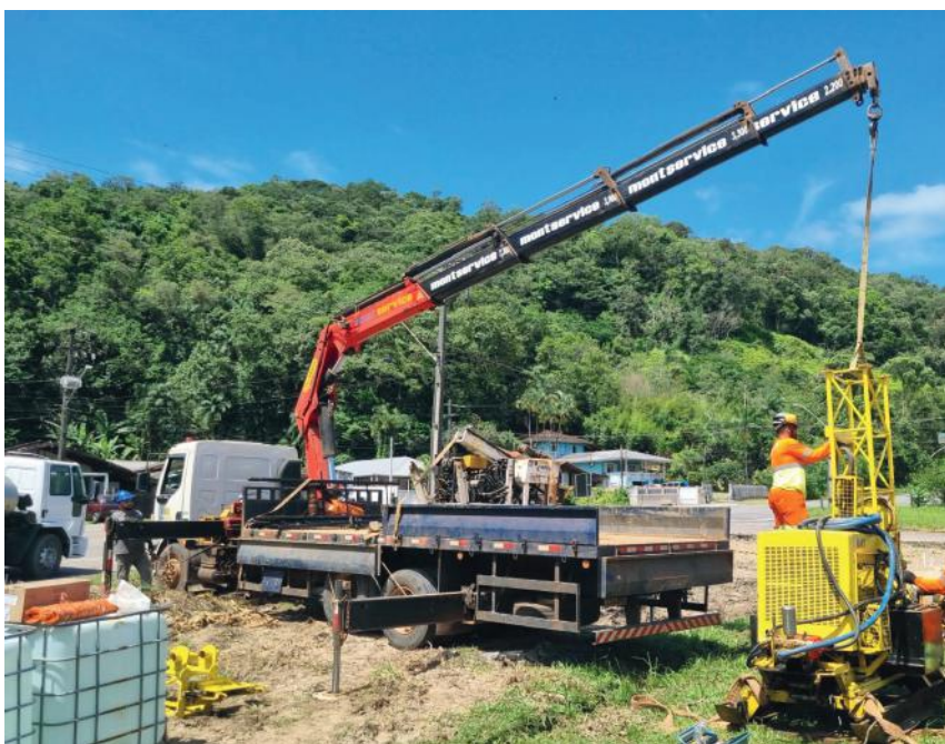
Obras no canteiro industrial. Imagem: CSPG.
