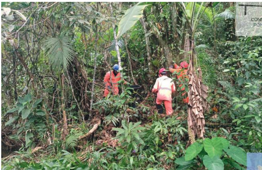
Equipe trabalhando na supressão vegetal. Imagem: CSPG.
