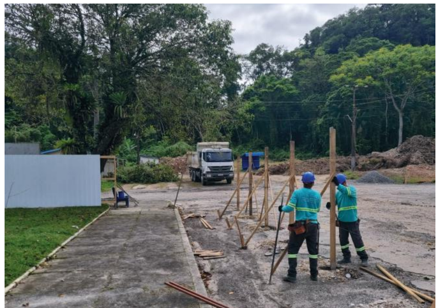
Obras no canteiro industrial. Imagem: CSPG.
